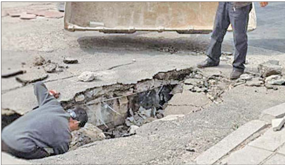
▲图为施工人员正在填深坑。 记者 李孟霏 摄
