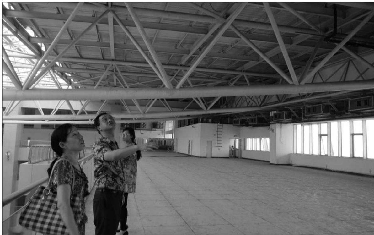
审计人员在淄博客运中心建设项目现场对钢结构及屋面排水系统进行实地勘测(资料片)。 本报通讯员 王浩 摄
