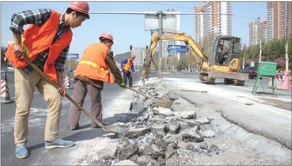
存在高度差路面已开始施工整治。 本报记者 王倩 摄
