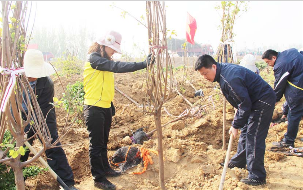
荆河绿化施工中。
