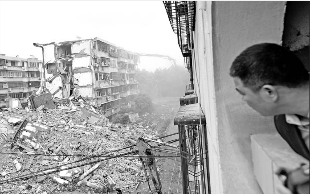
4月7日,奉化居敬小区第29幢楼,未倒的两个半单元被拆除。 CFP供图
