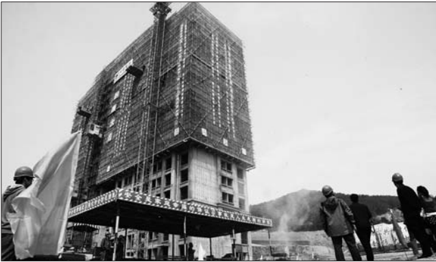
▲20日,公租房封顶现场,图为E9号楼外观。 见习记者 丛子茗 摄 优抚对象、孤老病残人员,以及符合廉租住房保障条件的家庭及新就业大学生,可以享受优先配租。
