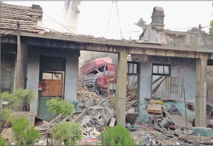
罐车撞进民房,房顶坍塌。 本报记者 王伟强 摄
