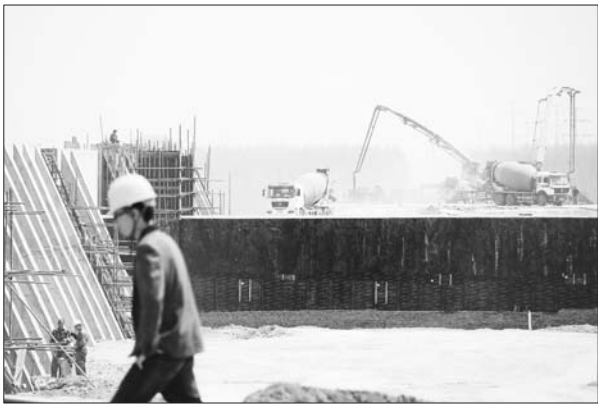
青荣城际铁路牟平站现场正在施工。 本报记者 李泊静 摄
