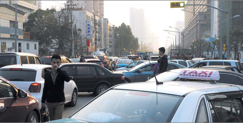
24日傍晚,和平路严重大堵车,整条道路成了停车场。因为25日夜间开始铺沥青作业,施工方为此将两侧道路封闭防止停车,导致道路变窄,而一些市民不听劝阻,将车辆继续往两边停,导致道路严重堵塞。 本报记者 周青先 摄
