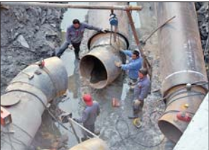
汽改水管道铺设。(资料图)
