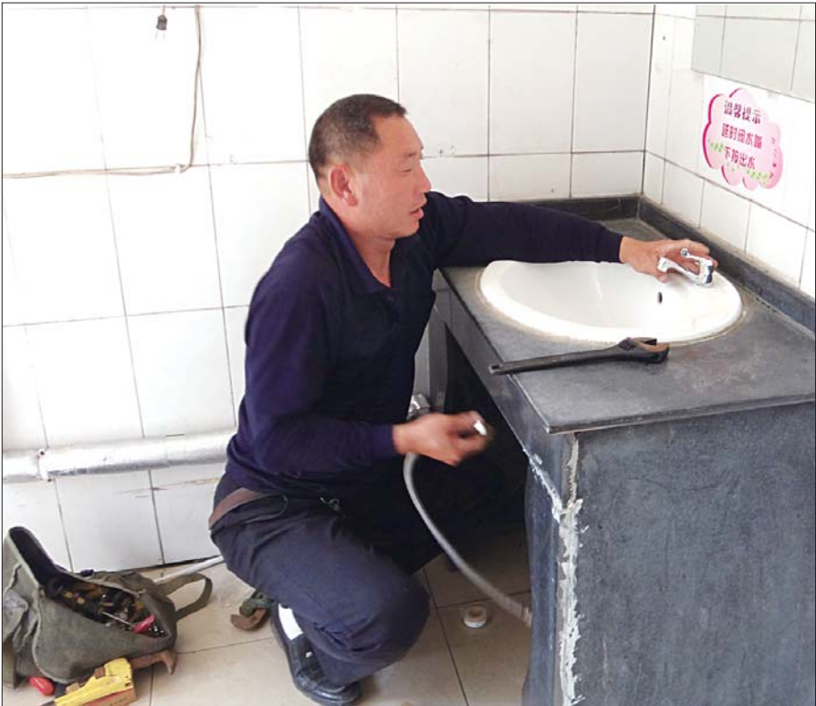
蓝尊物业公司的维修工正在维修水龙头。本报见习记者 齐兴 摄
