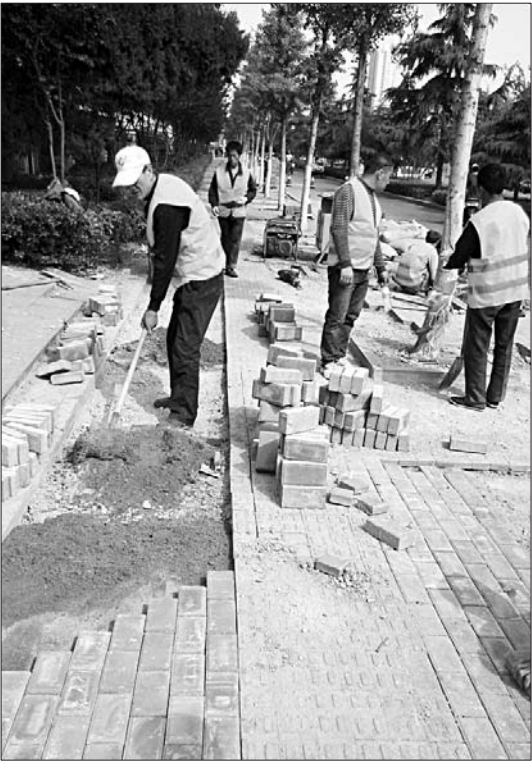
洸河路与古槐路交叉口,工人正在更换行道砖。公素云 摄
