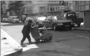
24日,市养管处的施工人员进行路面切割作业。 本报记者 张明媛 摄
