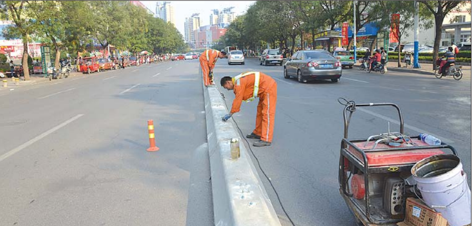
十几公里护栏,全部手工安装。
