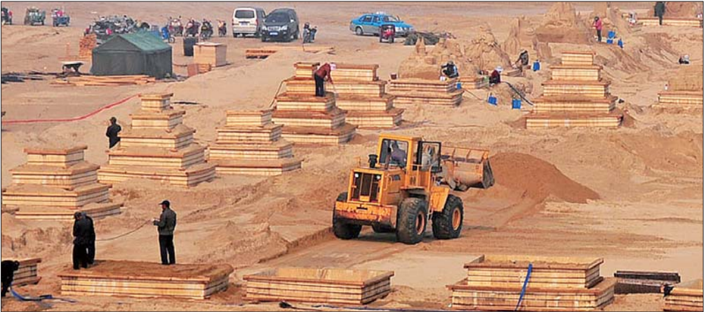
▲在东侧展区,工作人员在现场建造基体,每个基体需要4-5天的雕塑时间。
