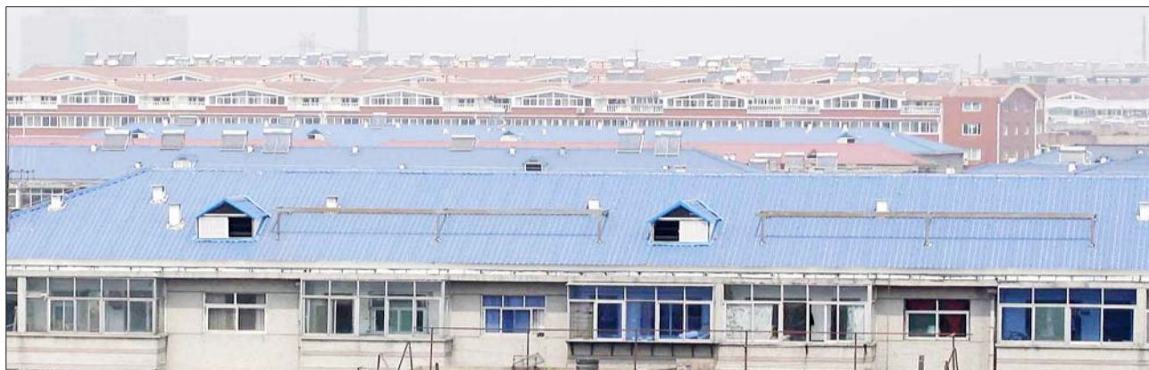
▲济南市有很多楼房进行了平改坡改造。本报记者 张中 摄
