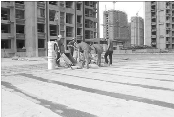
洛蒙防水工人在蜜橙小区现场施工。
