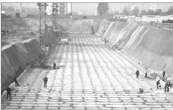
VPV卷材施工现场。
