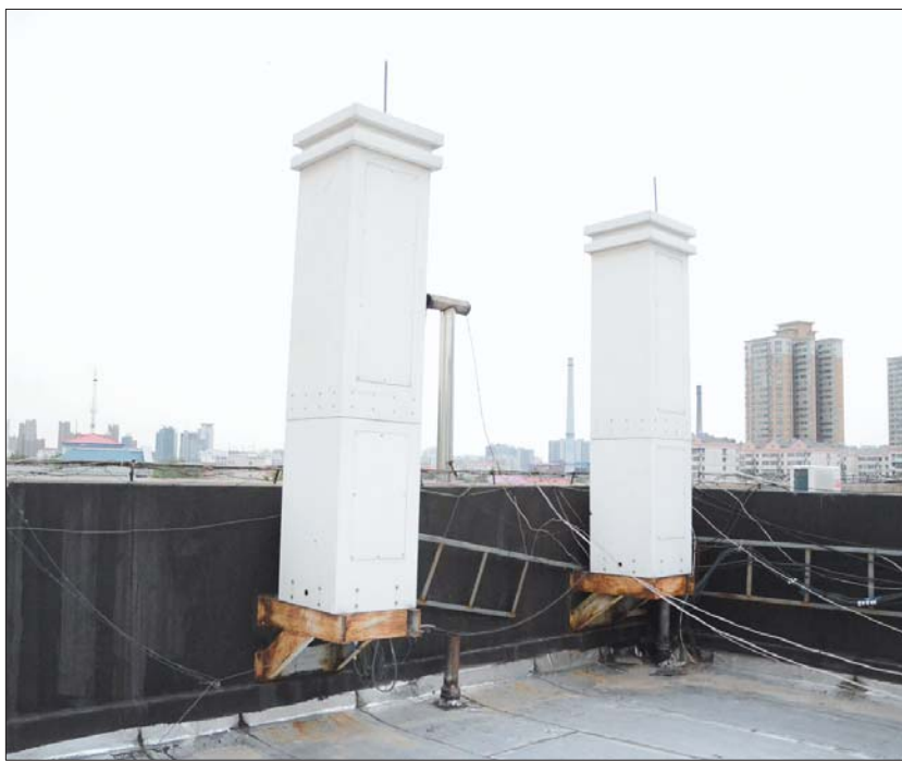
伪装成烟囱的通信发射基站。 见习记者 戚云雷
