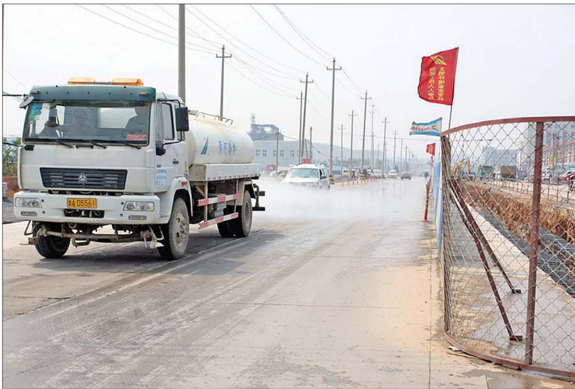
正在改造中的大正路。
