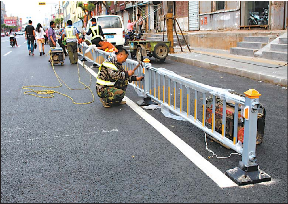
17日,和平路南北两侧开始安装护栏,以此将机动车和非机动车隔开。据现场施工人员介绍,和平路将安装3道隔离护栏,除南北两侧外,路中间也将立起高1.1米的护栏隔离南北车道。据悉,护栏安装完毕后,和平路面将不能再停车。 本报记者 李飞 摄影报道
