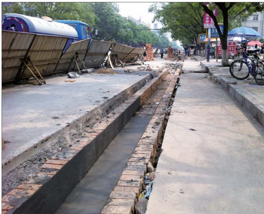
利民西路南侧正在铺设盖板涵沟。 本报记者 张召旭 摄
