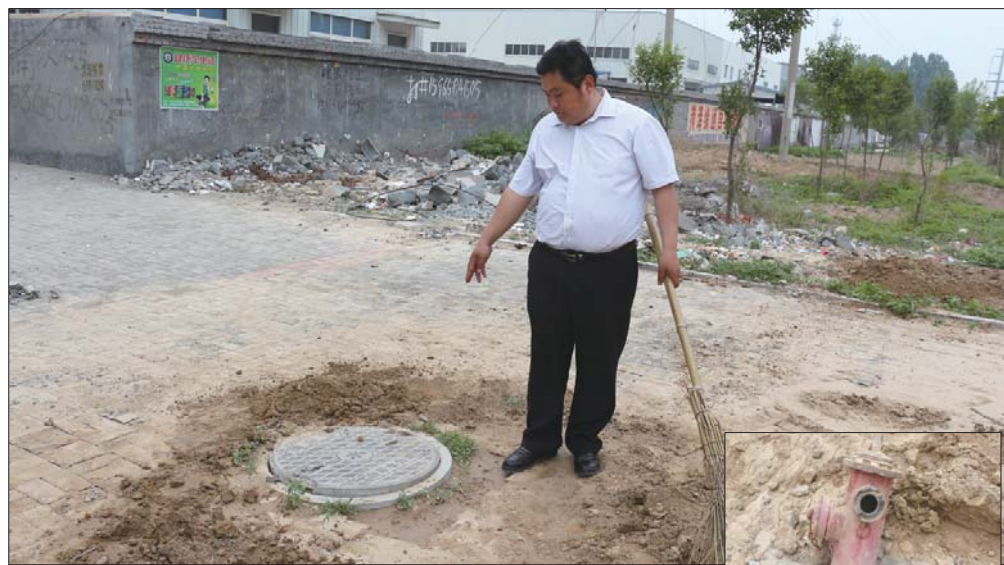
▲赵玉刚就是跳下这个管道关闭阀门的。本报记者 邢孟 摄 ▶正是这个损坏的消防栓往外冒水。本报记者 邢孟 摄
