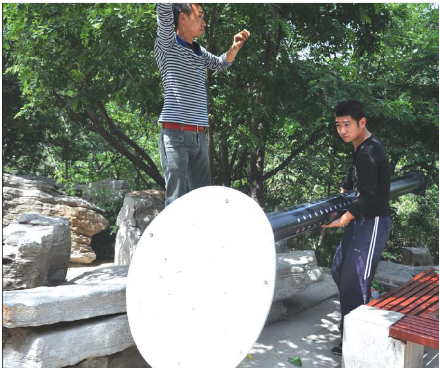
工作人员正在拆除原有的路灯灯杆。本报记者 公素云 摄
