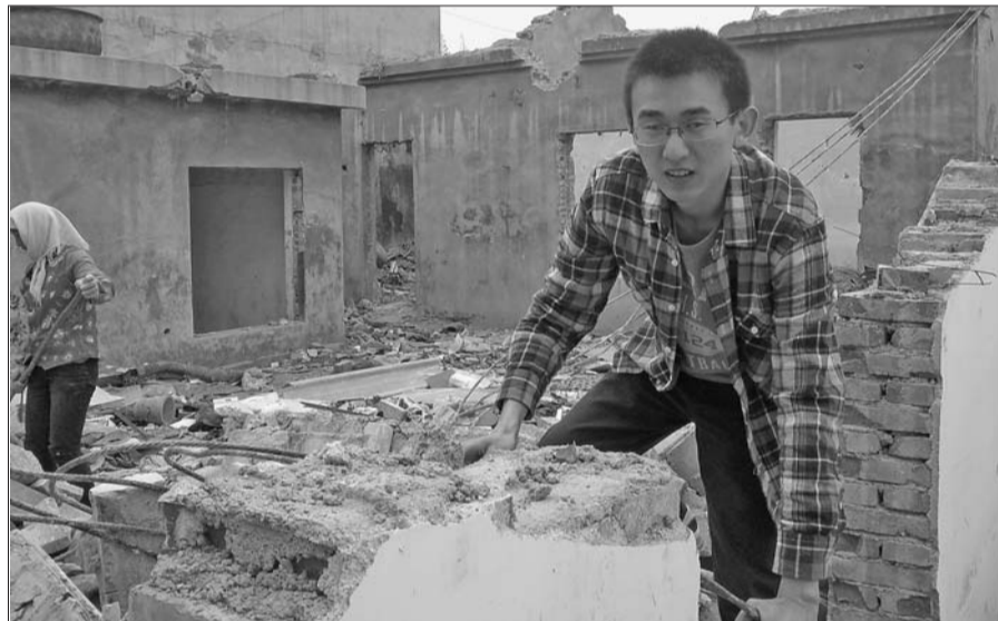
赵汉翔在任家村拆迁工地上。
