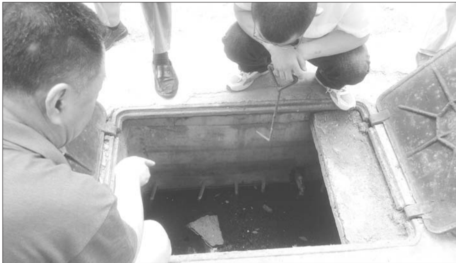
厚安街22号楼12户居民的水表多年来一直泡在污水里,这让居民心里很别扭。本报记者 张明媛 摄
