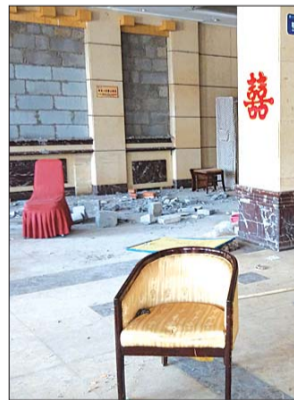
饭店大厅十分空荡,原有吧台已经被拆除。
