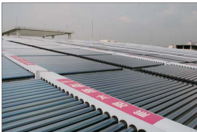
山东理工大学学生宿舍浴室太阳能改造项目。
