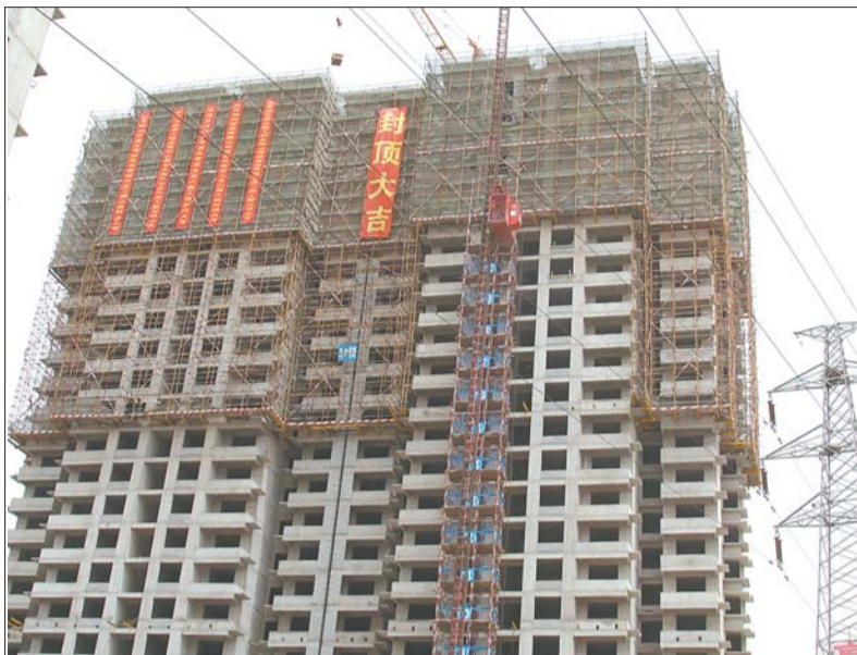
长兴美郡项目二期封顶仪式现场。
