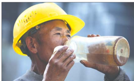
29日,市区最高气温达到35.3℃,环山路一工地上,62岁的电焊工艾红清汗如雨下,只能通过喝水和洗脸降温。
