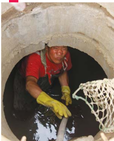
井盖下的清淤工。
