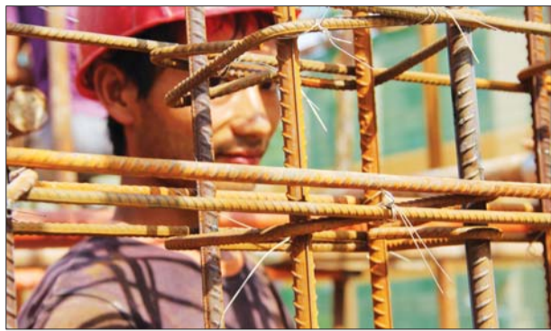
建筑工地上的钢筋工每天要搭建完成十个左右的架子。 本报记者 阙乐乐 摄
