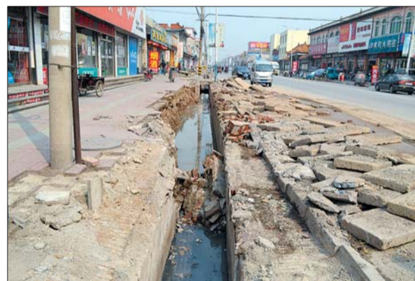
整修镇中心大街排水沟。
