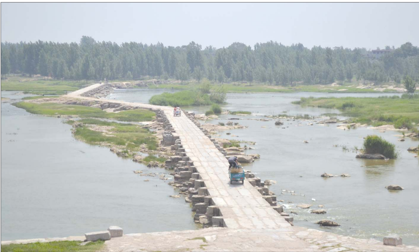
明石桥横跨大汶河。
