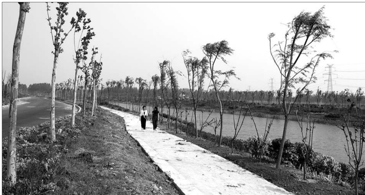
在临沂经济技术开发区,四条内河沿线建起了70余公里的慢行系统,成为市民休闲好去处。
