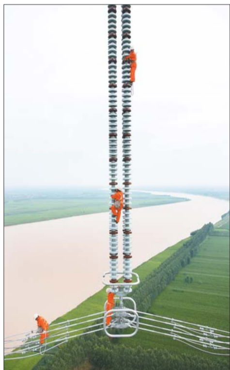
±660千伏银东直流输电工程黄河大跨越施工。 徐可 摄
