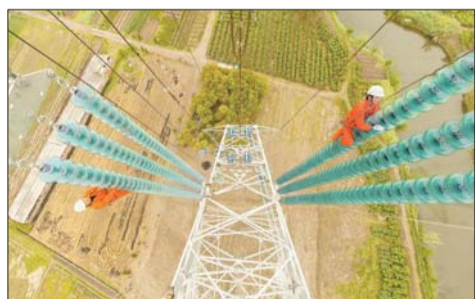
施工人员进行紧线施工作业。 徐可 摄
