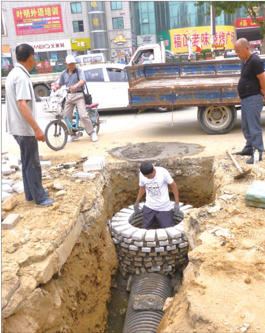
18日,福山区民阜路雨水管线进行改造,工人正在建检查井。该路段下雨就积水,本报曾进行报道。福山区高新技术产业园管委十分重视,投入近10万元对雨水管线进行疏通。本报记者 王伟平 摄
