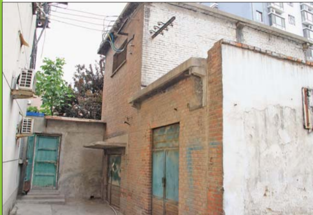
八号院内的变压器已经很陈旧。
