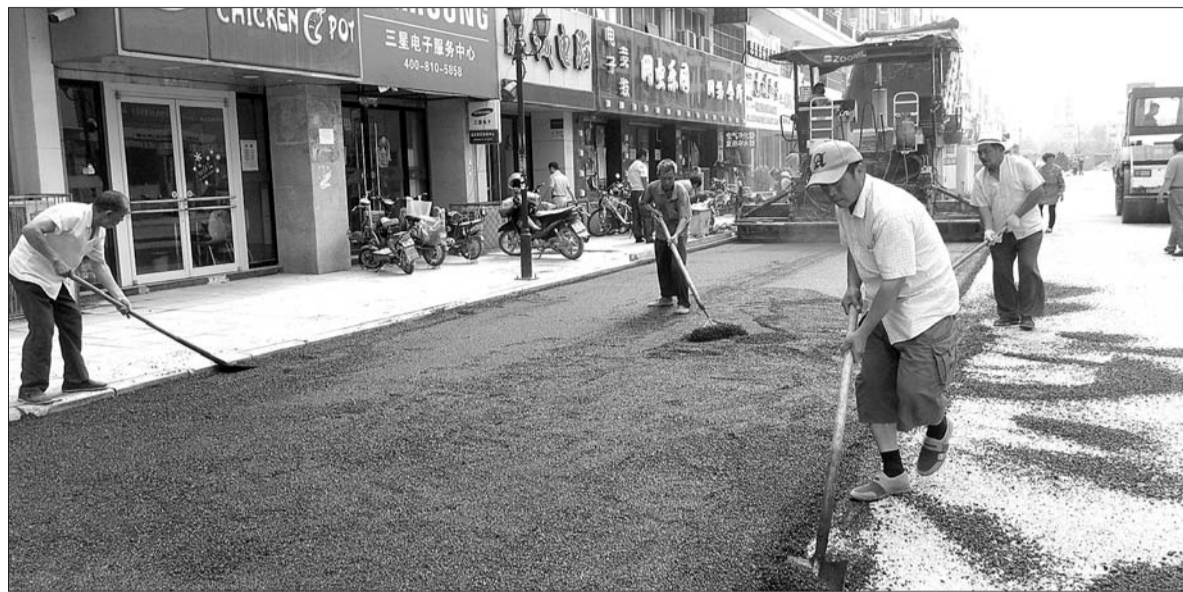
▲迎宾路正在铺沥青。
