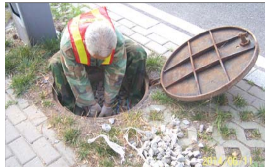
工作人员用石子盖住电缆,防小偷。 本报通讯员 摄
