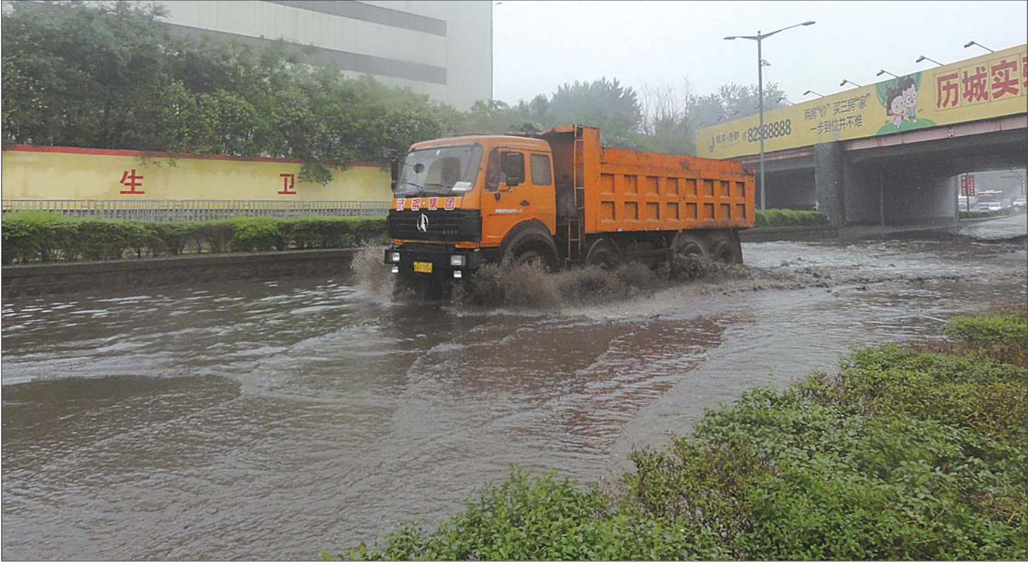
济钢铁路桥积水严重,有车经过便激起一片水花。 本报记者 张泰来 摄
