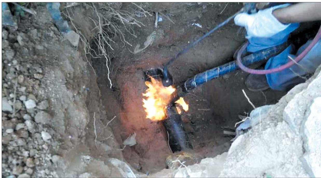
检查到破损点后,立刻开挖维修。
