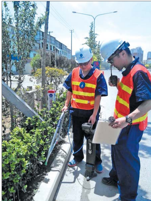
检测人员正在查管漏。
