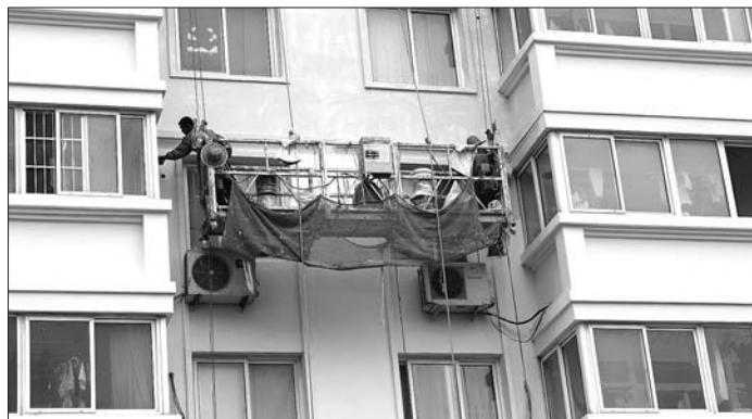
7月2日上午,施工人员在丽城花园进行外墙保温改造。
