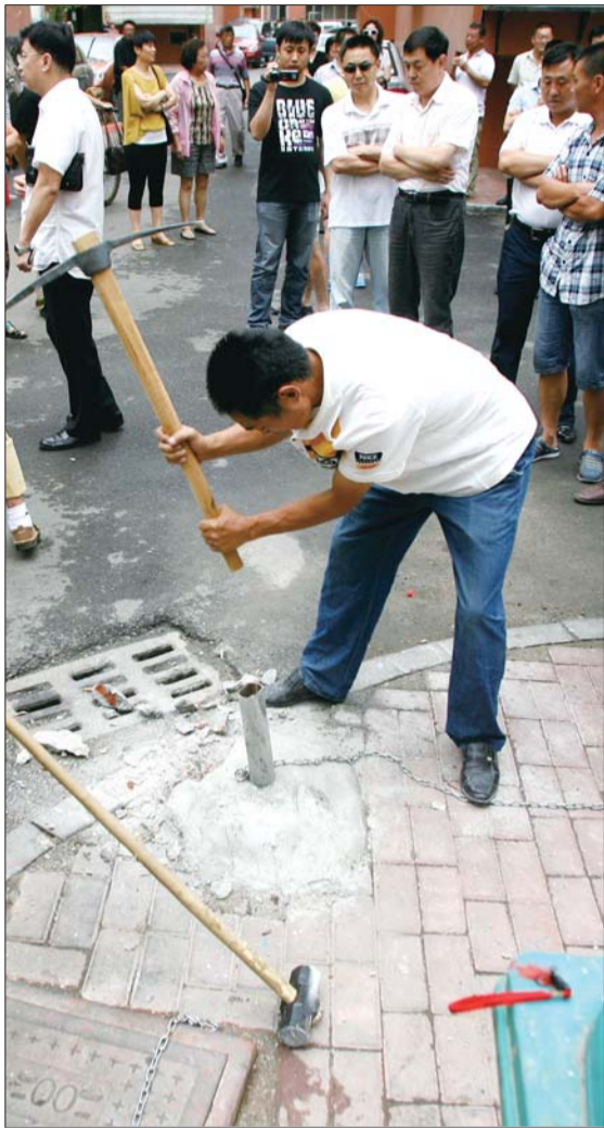
像工人正在拆的这种地桩,在一些老小区也有不少。 本报记者 赵金阳 摄
