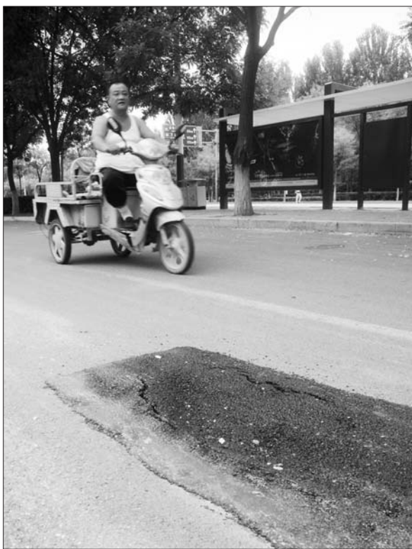
7月23日,三八东路晶华大道以东,多处道路下陷形成的路坑虽经修补,但仍出现新的下陷路坑。
