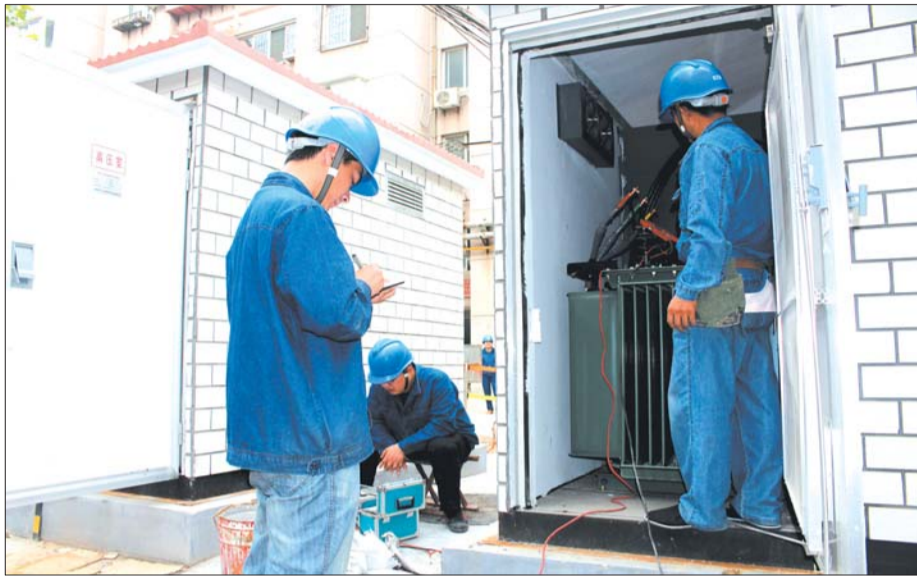
在仁丰家园,供电人员正在对新安装的两台箱式变压器进行投运前的耐压试验。 本报记者 李飞 摄
