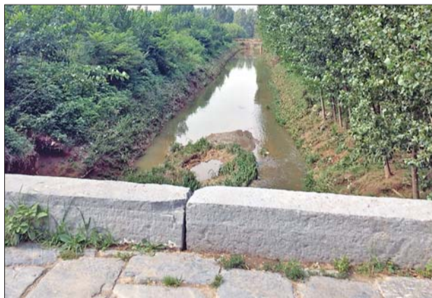
姜家桥仍是泄洪干渠小汉峪沟上的重要通行桥梁。
