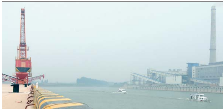
24日,洙水河航道巨野港各种大型设备已陆续安装完毕,执法船正在巡逻。 本报记者 邓兴宇 摄
