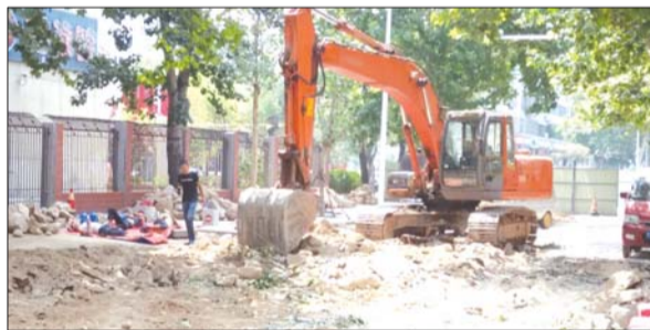
一台挖掘机正挖开路面。本报记者 侯峰 摄
