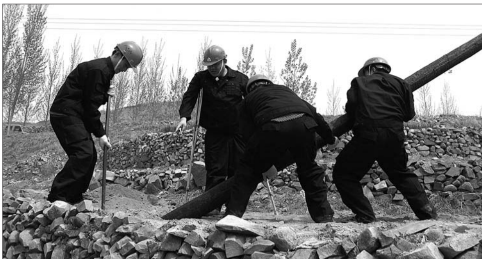
段文生正在跟同事们一起架设有线电视杆。(山东广电网络莒县分公司供图)
