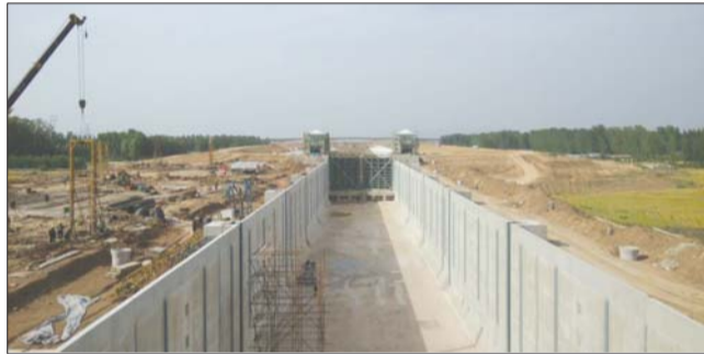
建设中的八里湾船闸主体。(资料片)
